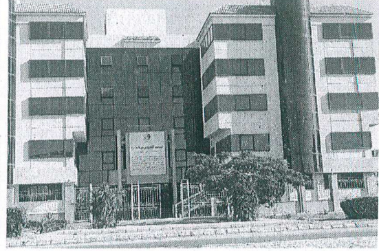
مبنى قسم الهندسة الطبية
