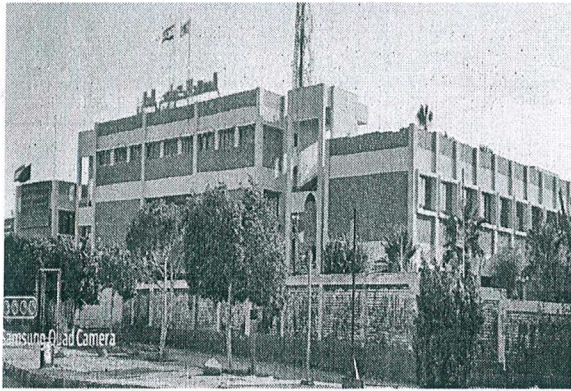
مبنى قسم علوم حاسب
