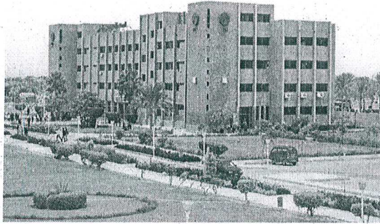
مبنى قسم الهندسة الميكانيكية
