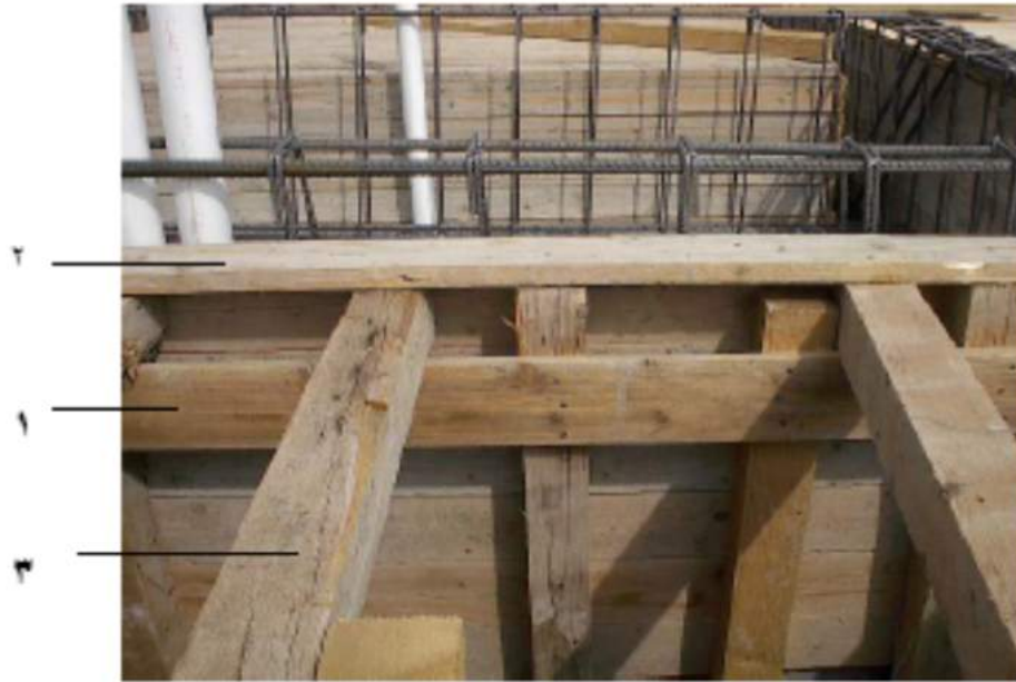
شكل رقم ( ٣٦ ) يبين لوح الزنق في جنب الكمره
