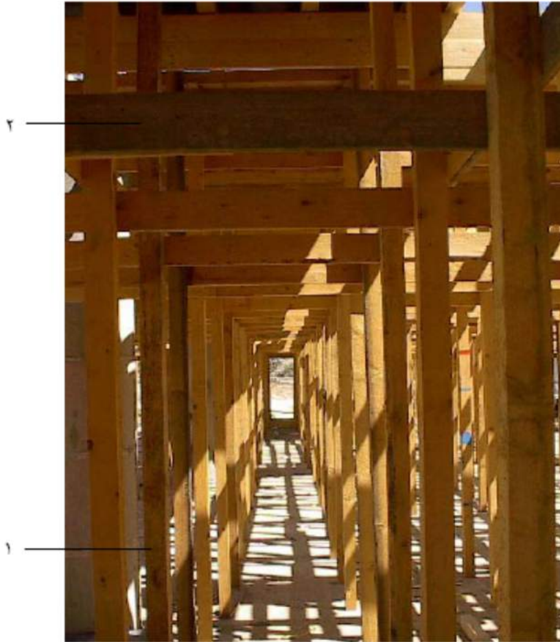
شكل رقم ( ٢٦ ) يبين وضع شمع القوائم الرأسية في صفوف منتظمة ويبين الشكل عدم وجود فرشات أسفلها لوجودها على أرضية من الخرسانة المسلحة
