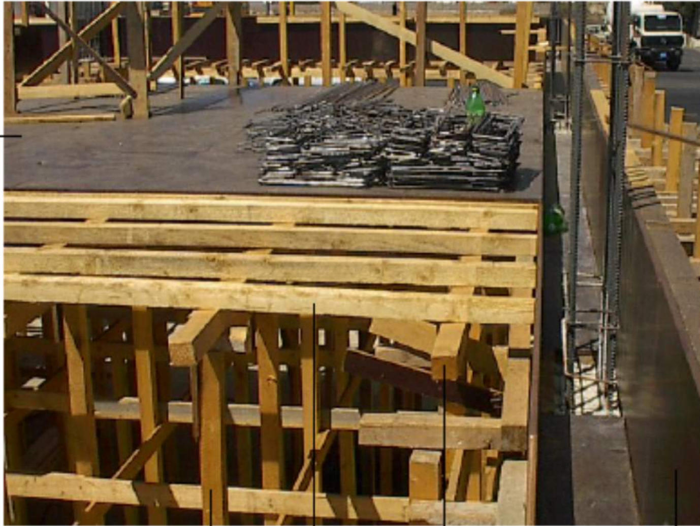
شكل رقم ( ٤٣ ) يبين بدء عملية التطبيق للسقف تمهيدا لعمليات الحداوة
